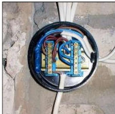
Подводку рекомендуется выполнять медным кабелем. Изоляция электропроводки, прокладываемой открыто, должна быть из не горючих материалов. Монтажные (распаечные) коробки, предназначенные для монтажа в них соединения проводов, не должны служить источником зажигания при возникновении в кабелях короткого замыкания, перегрузки или недопустимого нагрева в контактных соединениях.
