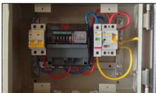
Для защиты от возгорания в доме должны быть установлены устройства защитного отключения тока в специальных несгораемых ящиках.
